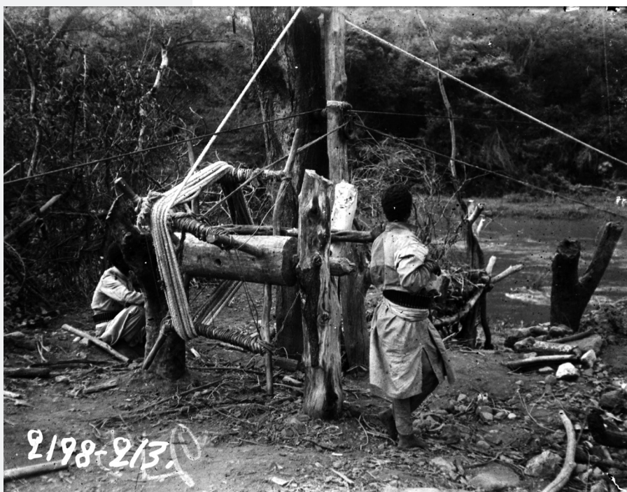
Н. С. Гумилев, Н. Л. Сверчков. «Подвижной висячий мост через реку Уаби. Ворот, приводящий мост в движение». 1913 г. МАЭ № 2198-213
